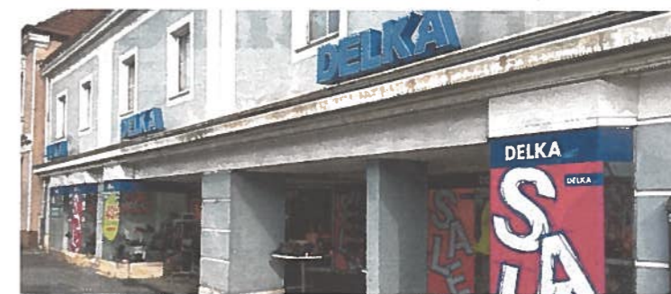
Delka möchte zwar in Zwettl bleiben, der Standort steht aufgrund seines Zustands jedoch infrage. Foto: bs
