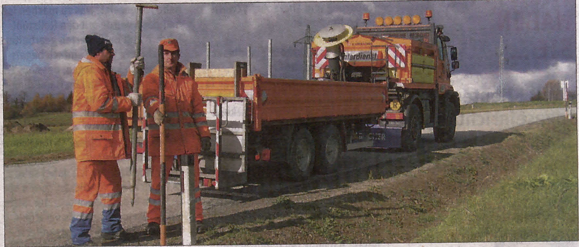
Derzeit werden von den Bediensteten – im Bild Norbert Traxler und Herbert Thaler von der Straßenmeisterei Zwettl – die Schneestangen entlang der Straßen gesetzt. Foto: Straßenmeisterei
